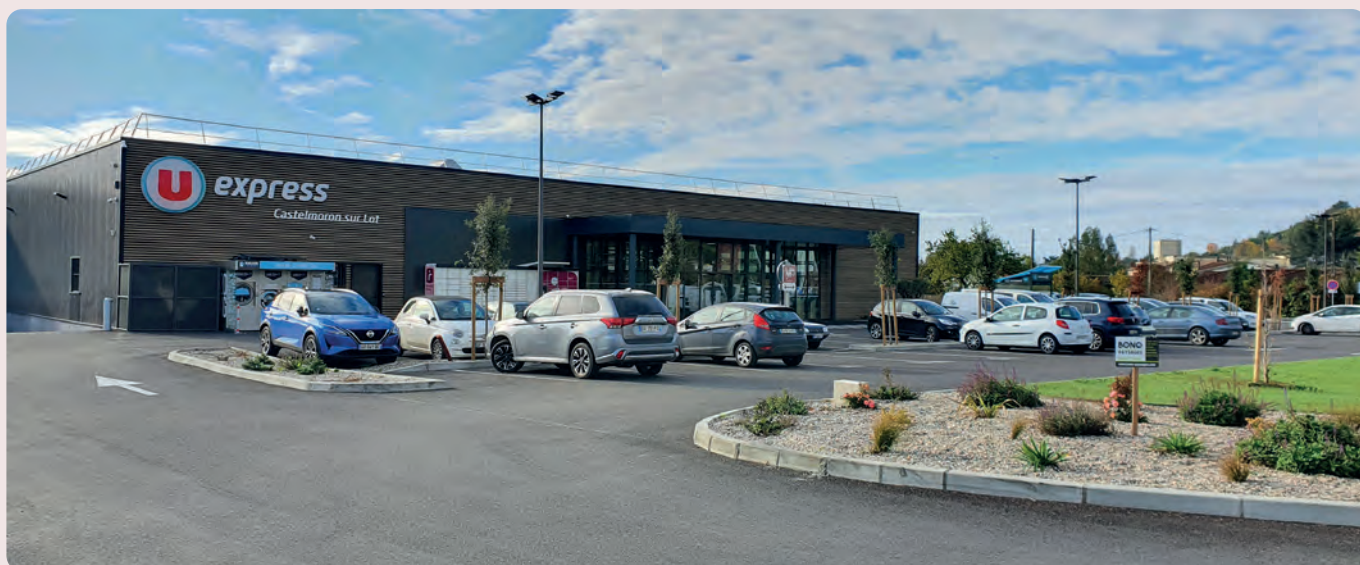
Ouverture le 1 er juin de U Express, surface commerciale de 885 m 2 , avec laverie automatique, parking, station essence, station de lavage voitures et location de véhicules utilitaires.
