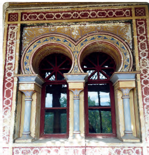
Baies intérieures dans galerie
