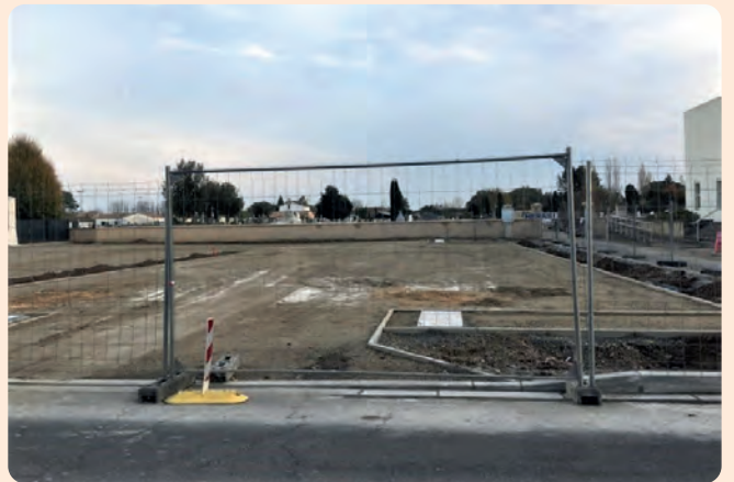
Travaux en cours d'un nouveau parking devant le cimetière et l'école primaire
