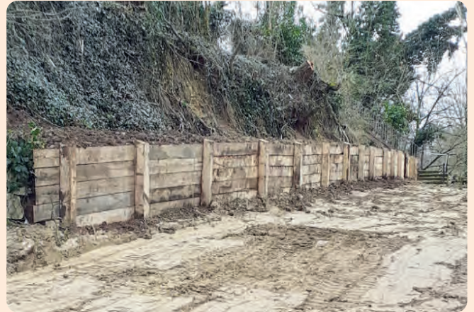
Travaux de renforcement et de soutènement des berges du camping-plage
