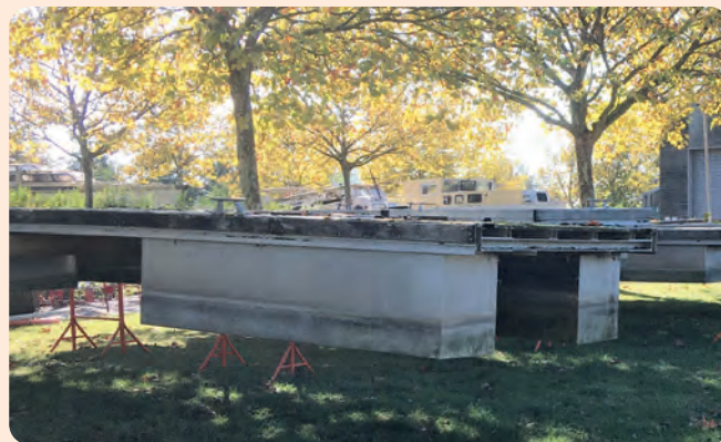
Les pontons 1,2,3 et 4 de Port Lalande, mis hors eau, pour contrôle et expertise en vue de leur homologation. Fin 2023 les pontons 5, 6 et 7 seront également contrôlés.
