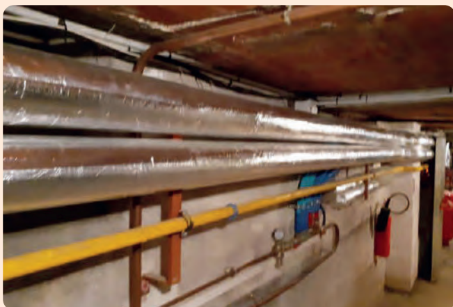
Le calorifugeage pour isolation des tuyaux chaufferie des bâtiments communaux
