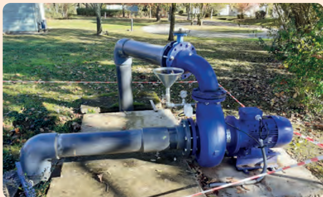
Installation d'une pompe d'alimentation en eau des petits ruisseaux de Port Lalande pour oxygéner et limiter l'envasement du bassin.
